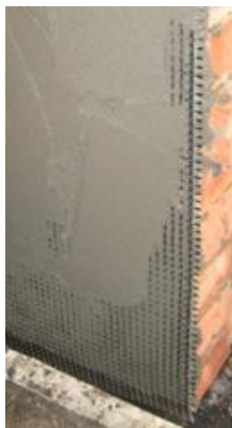
Д.1-сурет – Композиттік материалдан жасалған торлармен арматураланатын тас қабырға бөлігі
