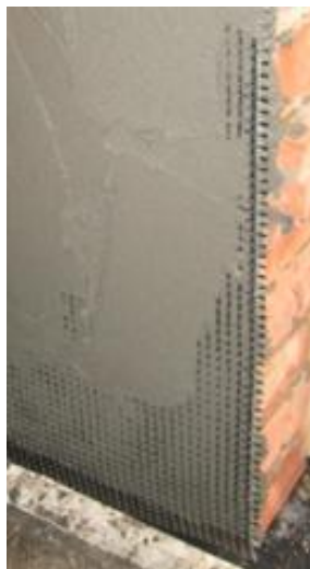
Рисунок Д.1 – Фрагмент каменной стены армируемой сетками из композитных материалов
